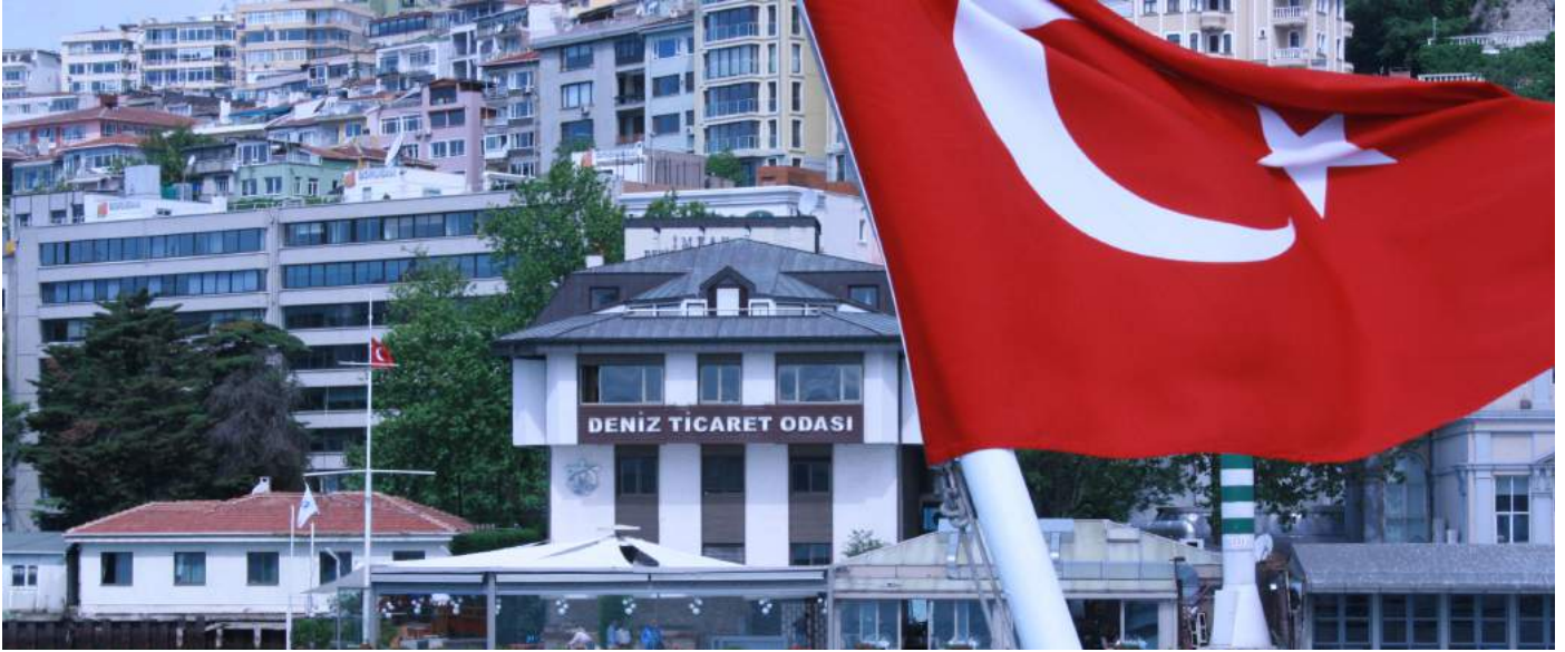
Resim 1 İMEAK DTO Hizmet Binası
